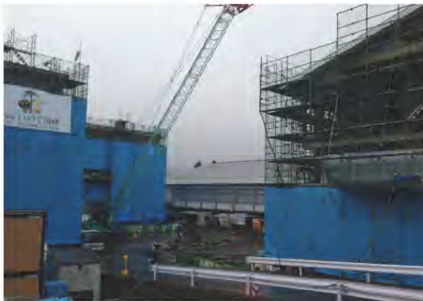
▲建設中の高田高等学校（2014年12月3日撮影）
