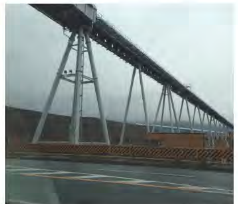
盛り土を運ぶためのベルトコンベア（陸前高田市）
